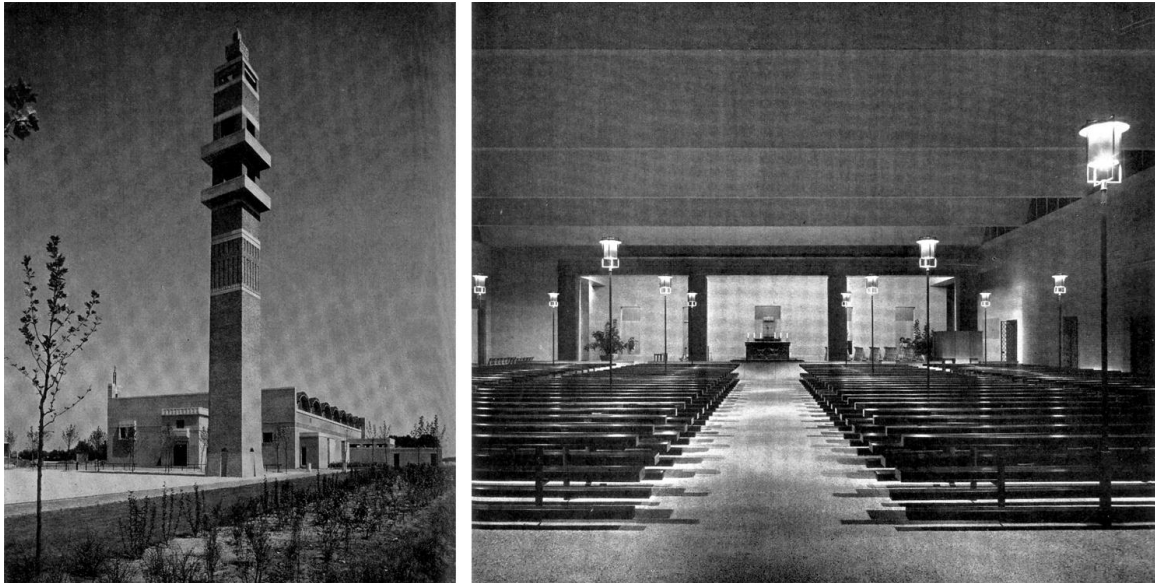
Afb. 8 Exterieur- en interieurfoto van de St.-Gerardus Majellakerk (1957-1959) in Gemert van de architect Jan de Jong. (uit: Van der Laan 1960, pp. 486, 487)
